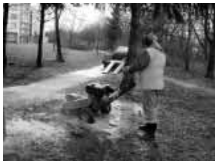
Frézování pařezů
